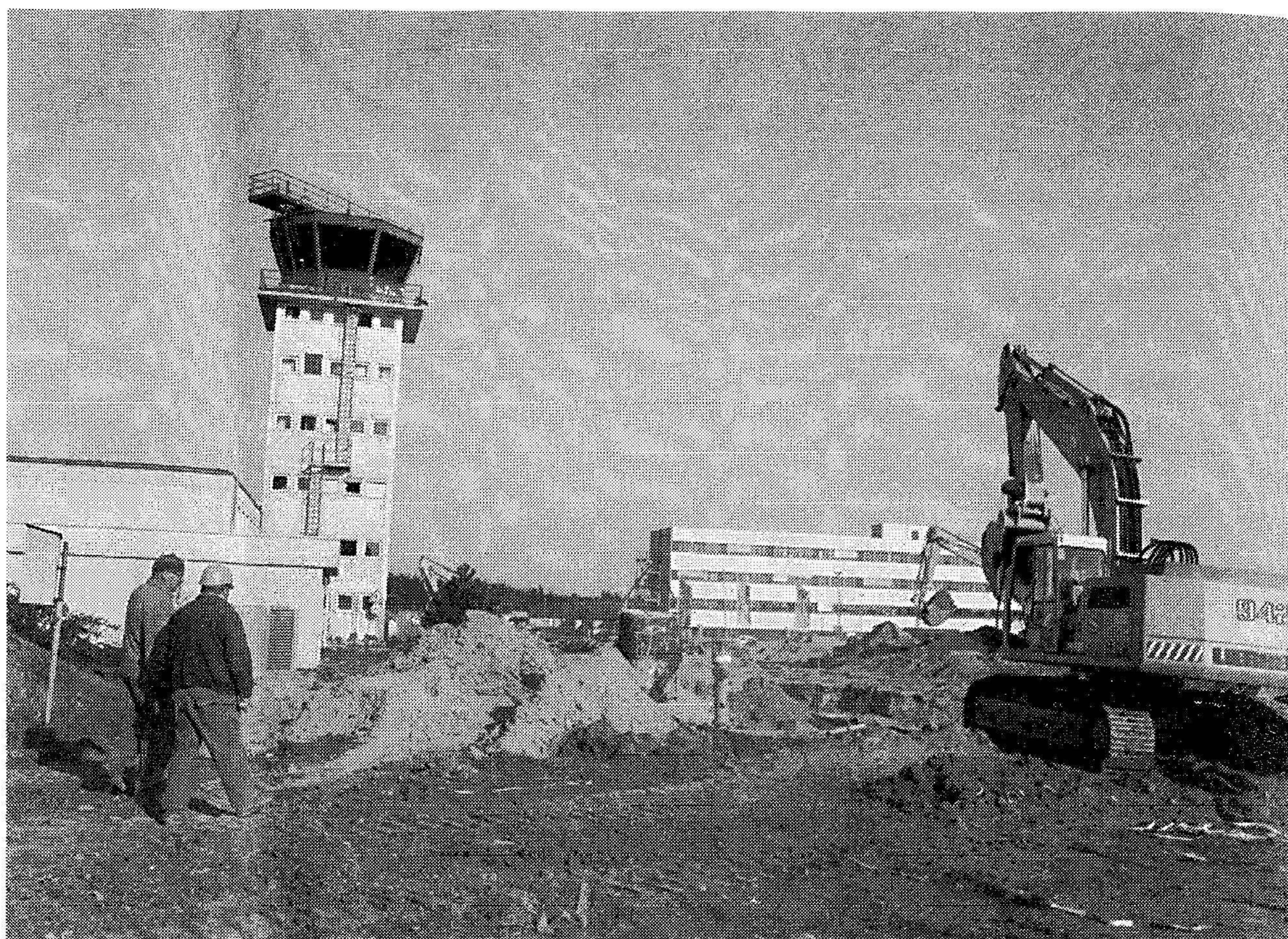
Im ersten Abschnitt wird eifrig an der Erschließung gearbeitet. Der alte Tower (links) bereitet dem GNF Sorgen. Fotos: Rüsing
