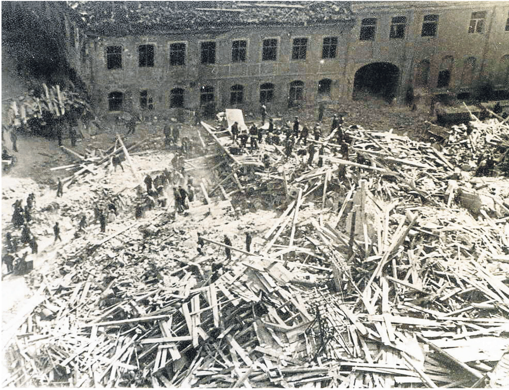
Der Lex-Saal und das Widmann-Haus wurden bei dem Bombenangriff auf die Stadt Erding am 18. April 1945 vollkommen zerstört. Die Fassade im Hintergrund ist das Gasthof zur Post. In den Lex-Saal hatten sich laut Zeitzeugenberichten besonders viele Menschen geflüchtet. Kaum jemand konnte lebend aus den Trümmern geborgen werden.
